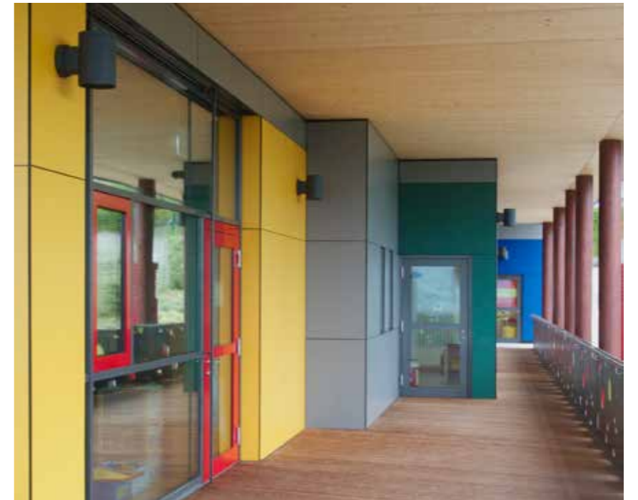
École secondaire | Lorentzweiler, LU
