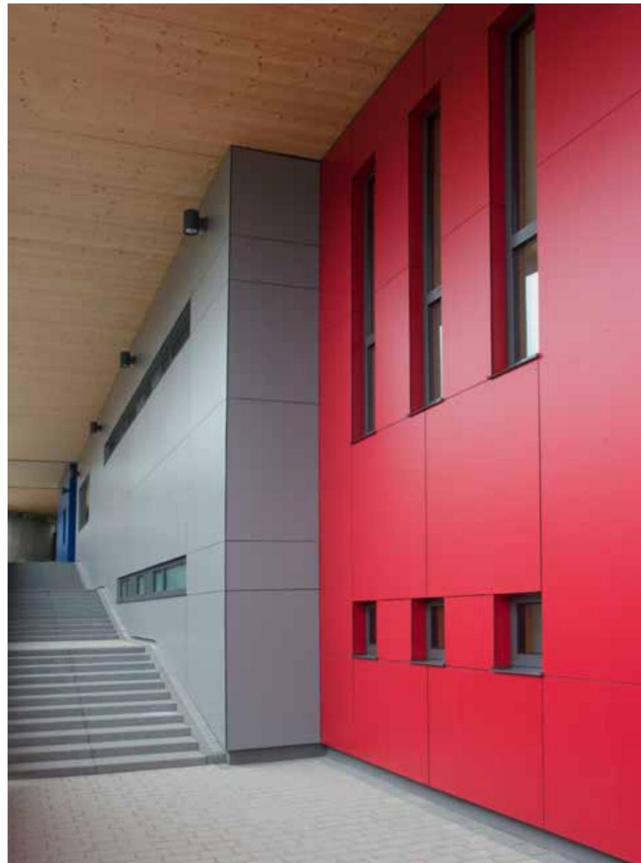
École secondaire | Lorentzweiler, LU
